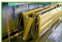
Hohlraumgrundierung Bord- und Aufsatzwände
