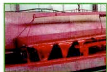
Cavity priming chassis frame and platform Полностан грунтова рамы шасси и площадки Az alváz és a plató üregvédelmi alapozása Grunduire cavităţi sasiu și platou
