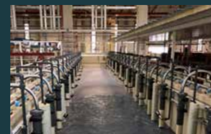
Rustbehandling Alle emner gennemgår 12 behandlinger i dyppekar.
