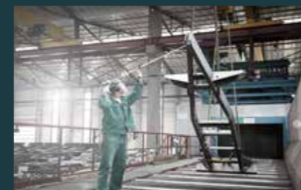
Mechanická předúprava tryskáním pro čisté a homogenní povrchy
