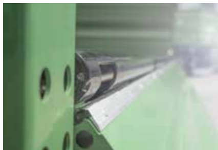
samočišća ivica mosta na sve četiri strane oivičena
